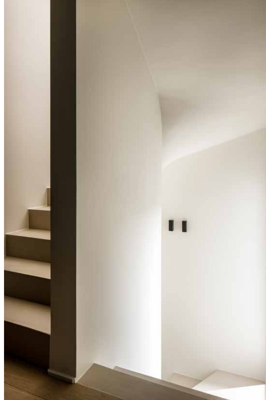
De trap heeft een afwerking van microtopping aangebracht door Texture Painting.
